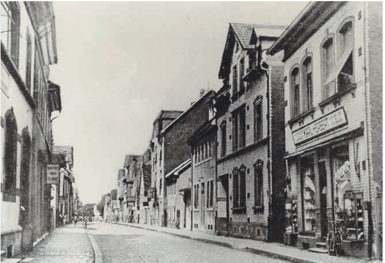
Hauptstraße, 1920er/30er Jahre. Die Straße hat eine städtische Anmutung entwickelt. Rechts die Häuser Nr. 30 und 30a.
