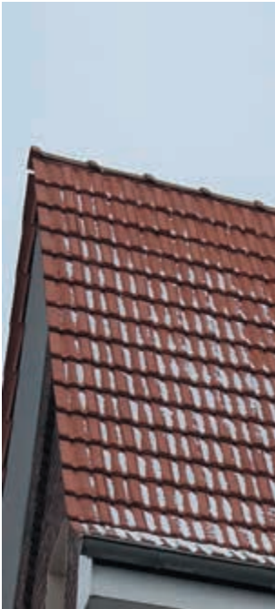
Satteldach mit roter Ziegeleindeckung
