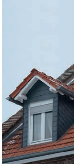
Mit Schiefer eingekleidete Dachgaube
